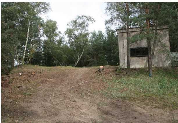
Trafohäuschen und Baufeld 2011
